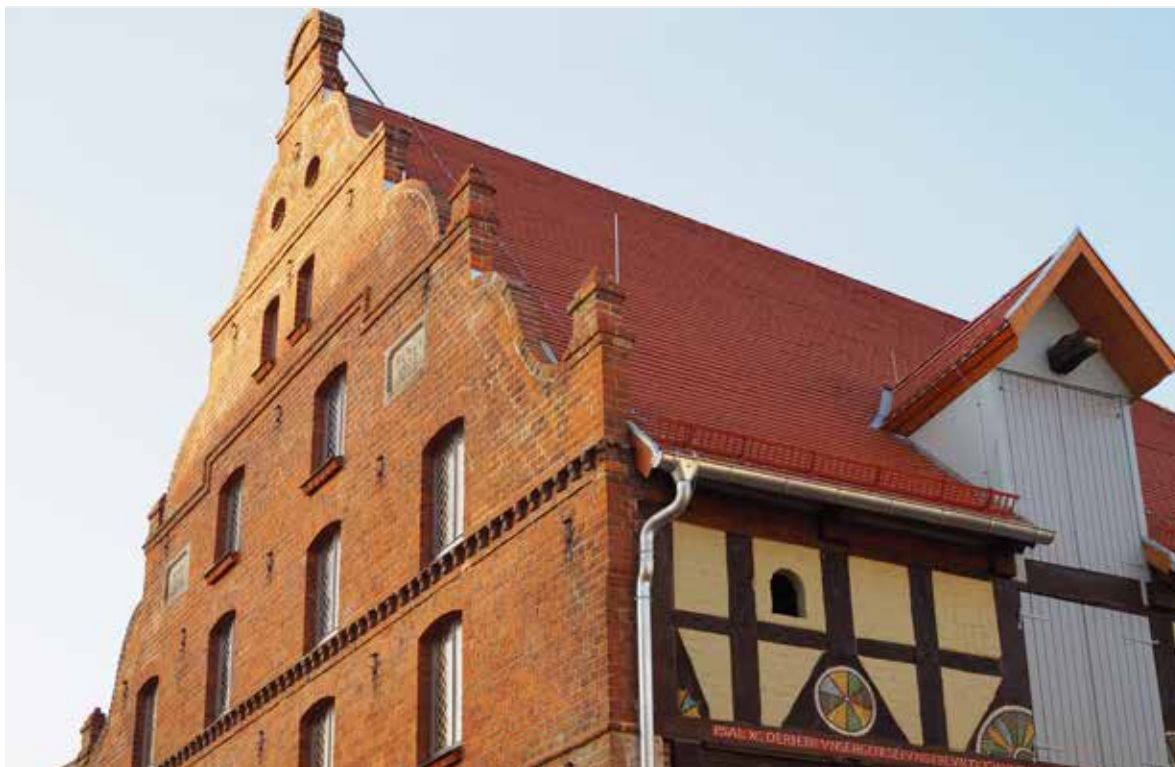
Das Giebelhaus in Parchim im Fokus des ersten Denkmalgesprächs
