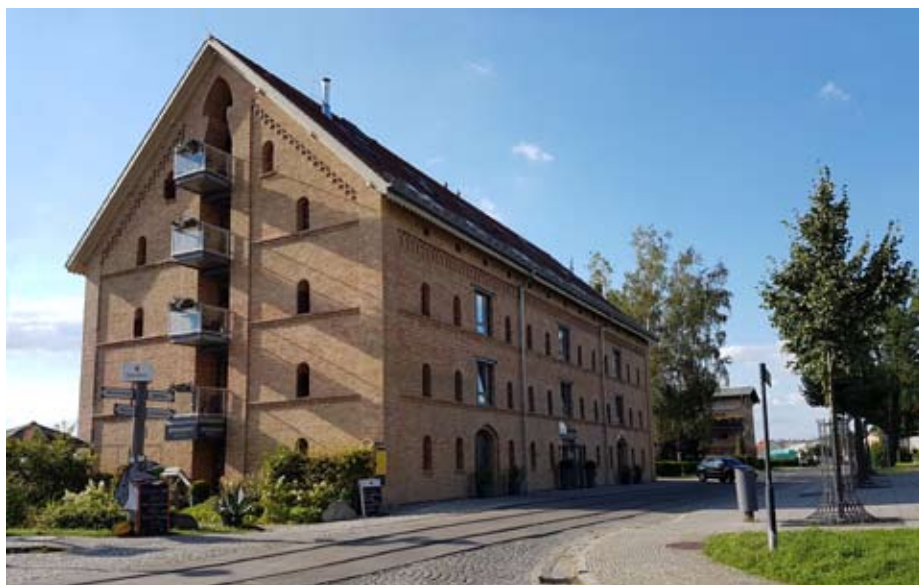
Alter Kornspeicher am Stadthafen Neustrelitz nach seiner Instandsetzung und Neunutzung | Fotos: Lutz Braun
