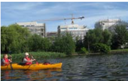
Neues Wohnquartier Holzhalbinsel (im Bau).
