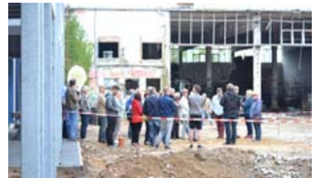
Schwerin: Baustellenführung auf dem Areal ‚Alte Brauerei‘ | Foto: Stefan Vorwerk, Schelfbauhütte
