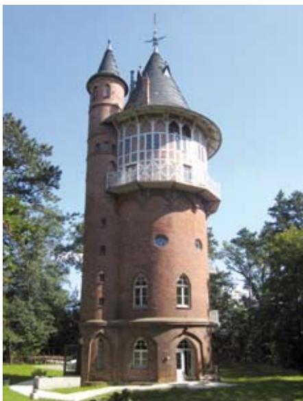
Der Wasserturm in Waren nach der Sanierung – Westansicht | Foto: Bewahren Ferienhaus eG
