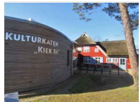
Kulturkaten „Kiek-In“ steht für traditionelle und moderne Architektur in Prerow | Foto: René Roloff
