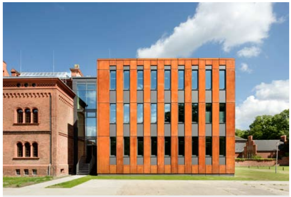
Neubau des Grundbuchamtes in Greifswald (Architekt: Maik Buttler) | Foto: Thomas Ulrich
