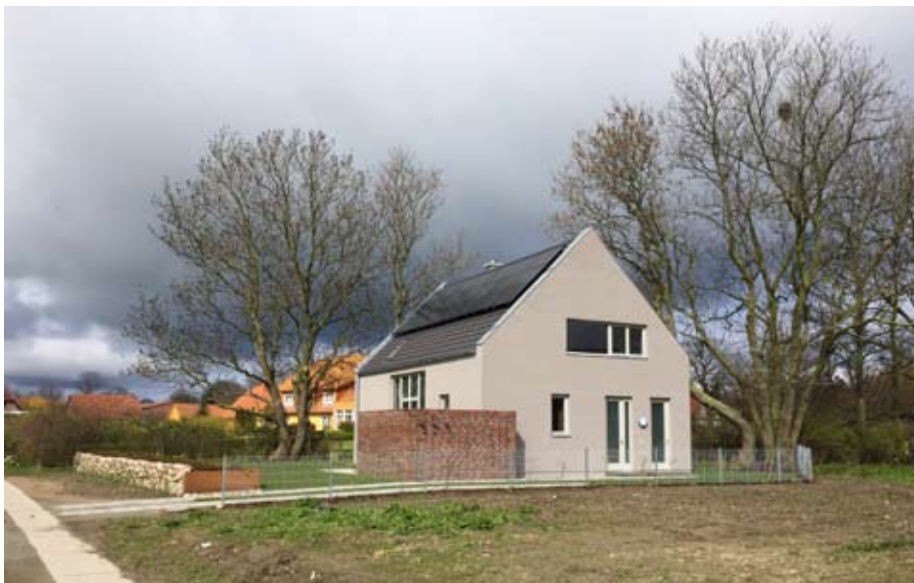
Wohnhaus in Putgarten auf Rügen (Architekt: Heinrich Rauschnig) | Foto: Olaf Bartels
