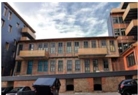
Der jetzt zweigeschossige Fachwerk-Mittelbau ermöglicht Ausblicke auf den offenen Innenhof | Foto: André Thölken, forejt architekten und partner mbB
