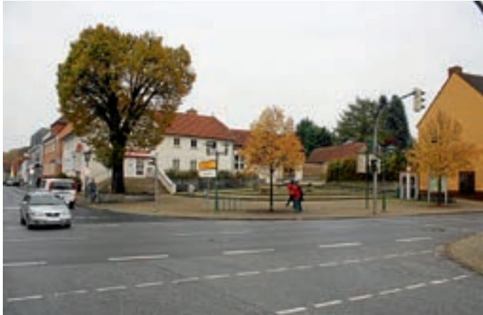
Ein Problembereich: Straßenkreuz Schlossstraße (B198)/ Fleether Weg mit kleiner Marktplatzsituation | Foto: AK M-V
