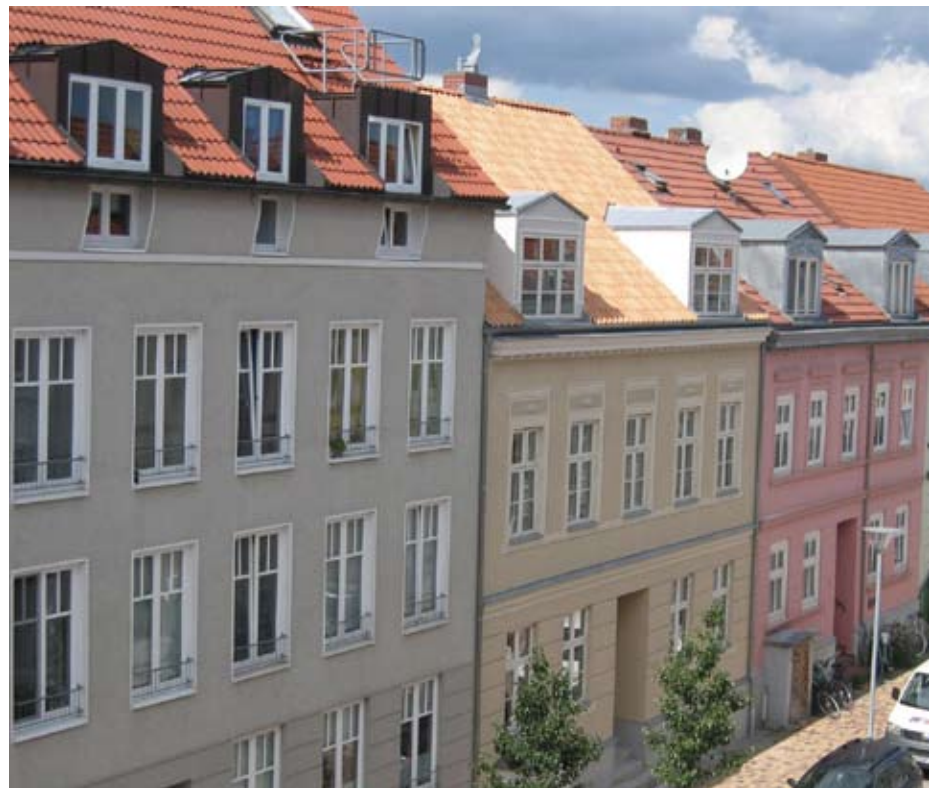
Sanierte Mehrfamilienhäuser in der Steinstraße der Fleischervorstadt | Foto: Drebing Ehmke Architekten
