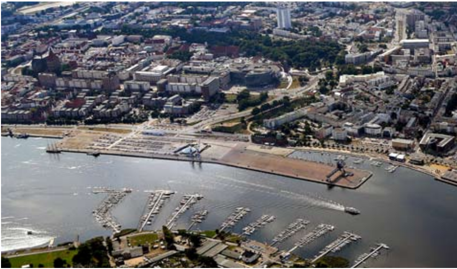
Der Planungsraum des Wettbewerbs umfasste einen ca. 13 ha großen Bereich nördlich der Innenstadt | Foto: Bernd Hagedorn, Rostock
