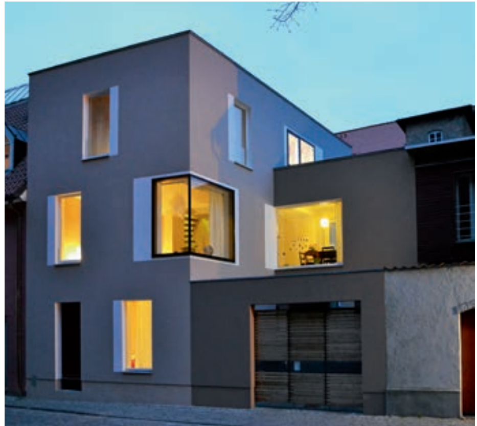
Wohnhaus in der Papenstraße 11, Stralsund (Gnadler Meyn Weitassek Architekten Innenarchitekten) | Foto: Gnadler Meyn Weitassek Architekten Innenarchitekten
