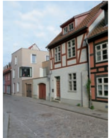
Wohnhaus in der Papenstraße 11, Stralsund | Foto: Olaf Bartels
