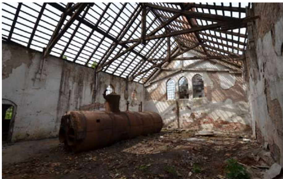
Die Maschinenhalle der ehemaligen Landesirrenanstalt Domjüch in Neustrelitz kann u. a. am 8. September besichtigt werden | Foto: Klaus Mebus
