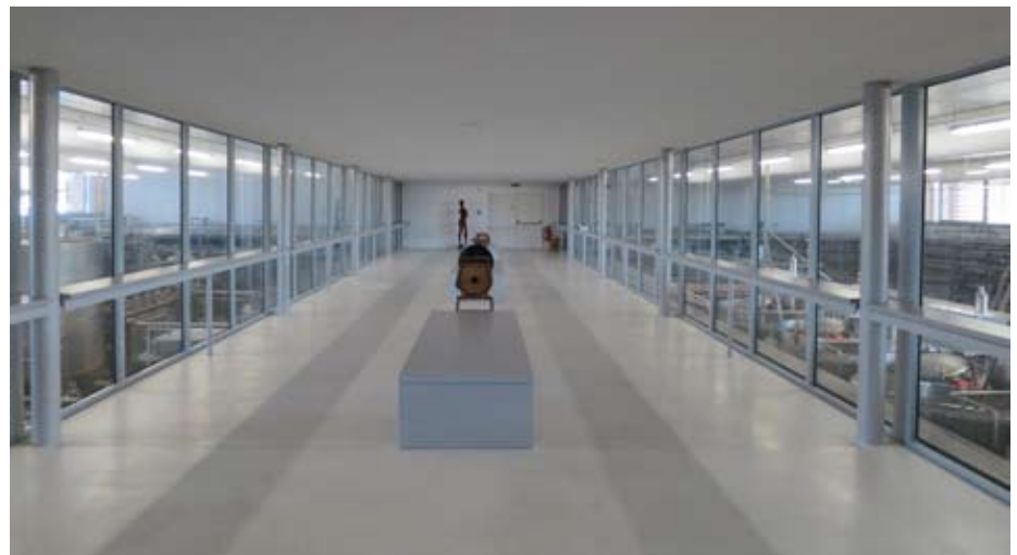
Die „Gläserne Meierei“ in Dechow, Blick in den gläsernen Gang zur Besichtigung der Produktion (Architekt: Jakob Lehrecke) | Foto: Olaf Bartels
