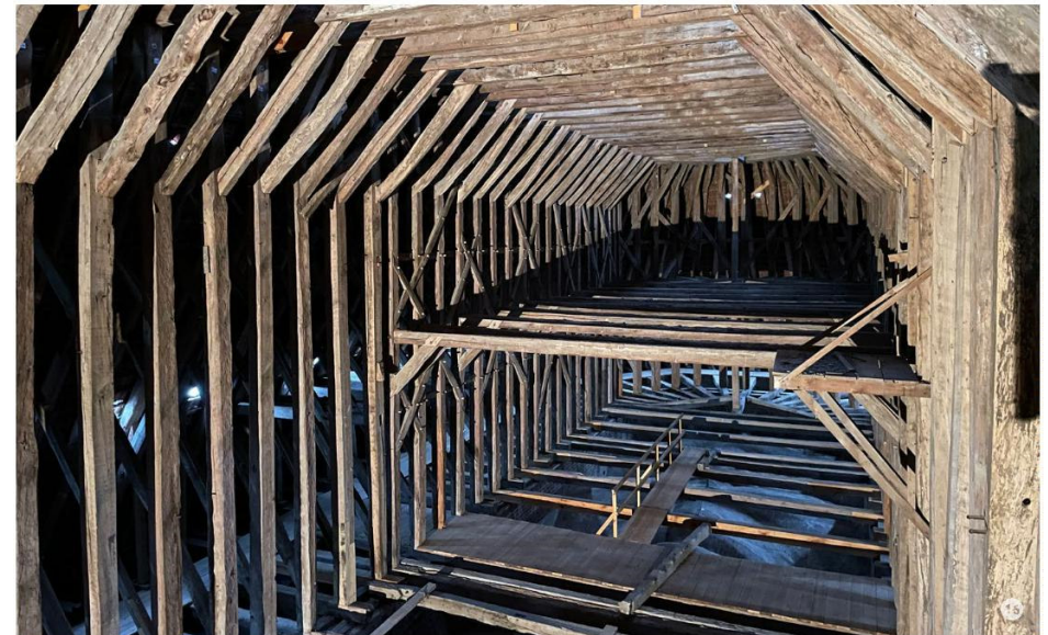
Dachstuhl Kirche St. Peter, Altentreptow
