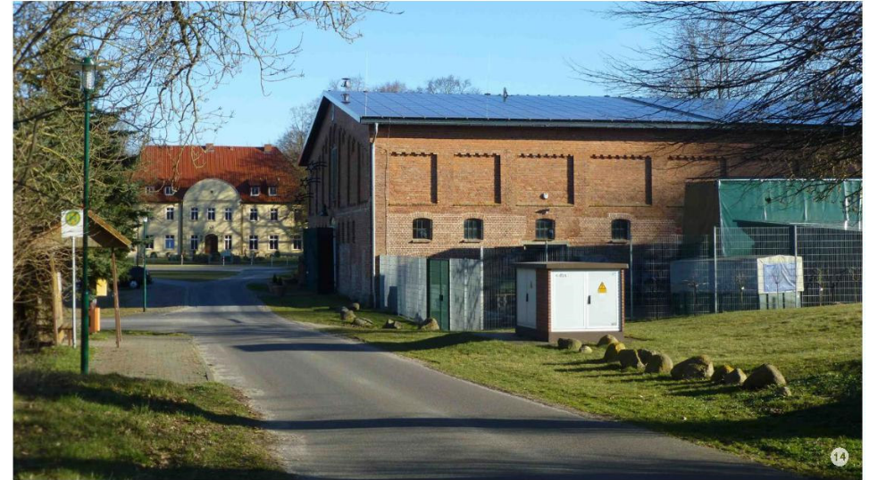
Ehemaliger Kuhstall, Einzeldenkmal und Teil einer denkmalgeschützten Gutsanlage
