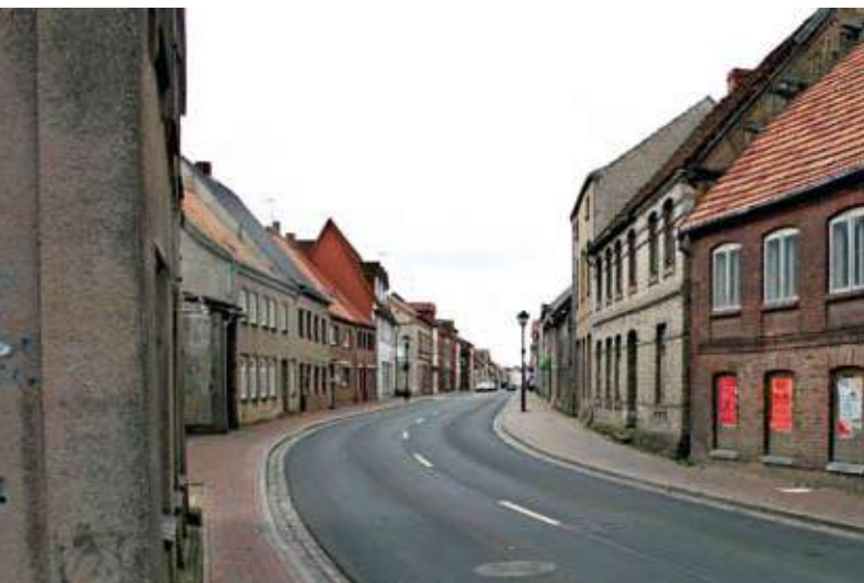
20-30% der Gebäude in der Altstadt von Goldberg stehen leer
