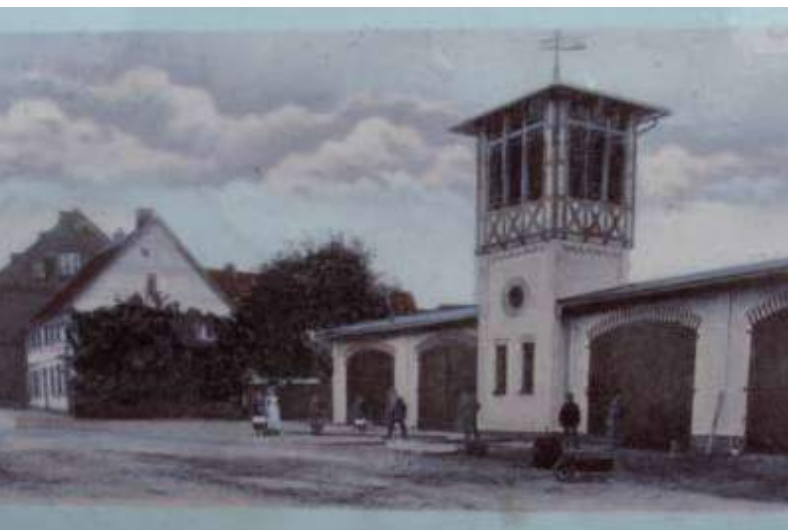
Das Feuerwehrhaus in besseren ...
