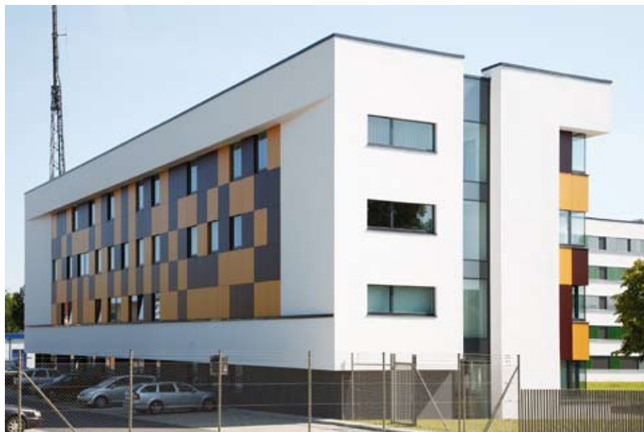
Umbau eines Plattenbaus für die Bundespolizei in Mecklenburg-Vorpommern, Architekten: Bastmann+Zavracky BDA Architekten GmbH, Rostock
