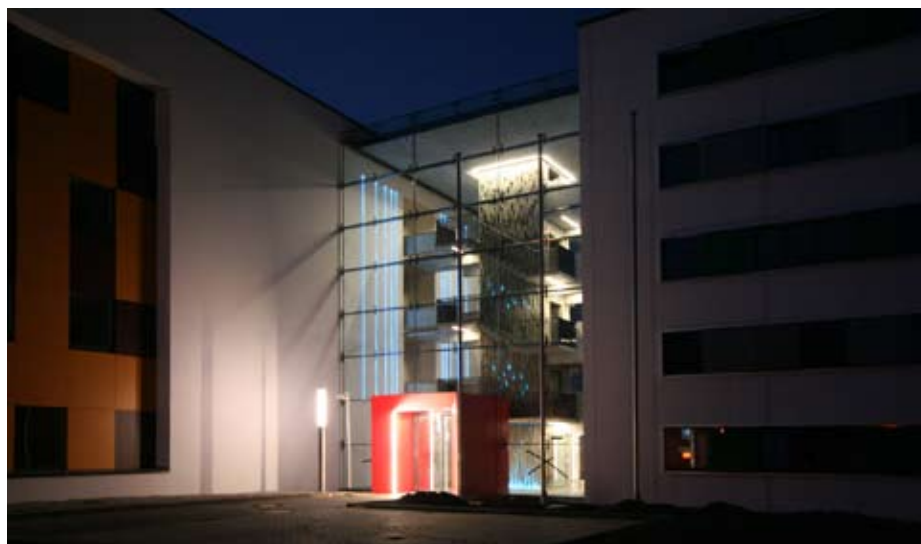
Umbau eines Plattenbaus für die Bundespolizei in Mecklenburg-Vorpommern, nächtliche Eingangssituation Architekten: Bastmann+Zavracky BDA Architekten GmbH, Rostock
