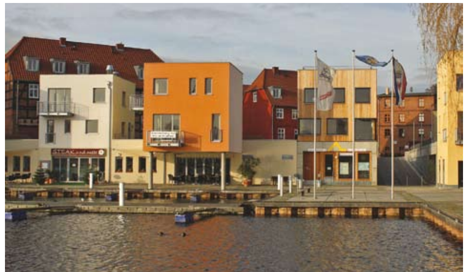
Die neue Bebauung am Stadthafen in Malchow nach einem städtebaulichen Entwurf von Kara & Hoffmann Architekten (vormals Steidle + Partner Berlin), Architektur: Nuckel Architekten, Selisko-Löber im Büro Löber. Ingenieurtechnische Planung der gesamten Anlage: Büro Löber. Die Hafensteinstadt befindet sich in dem zweiten Gebäude von rechts.
